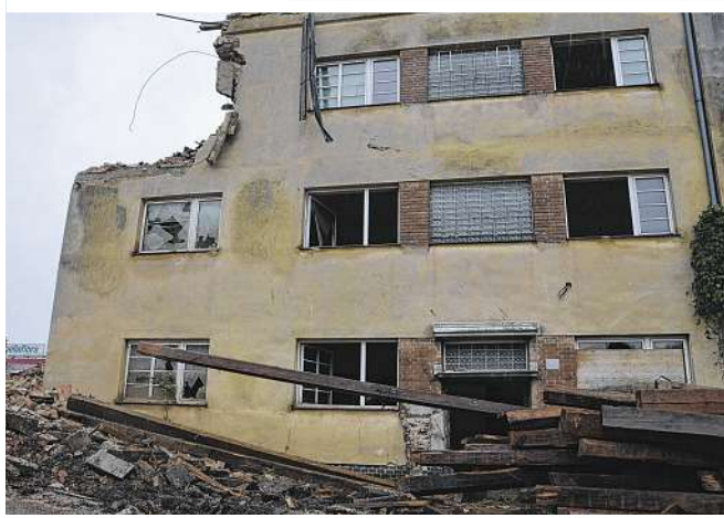
Die Abbrucharbeiten haben bereits Ende August begonnen
