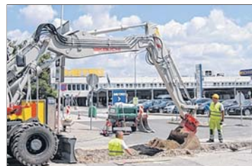
Die Bauarbeiten laufen auf Hochtouren. Foto: Purer
