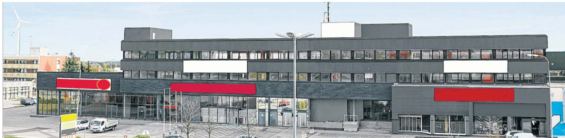
Das zukünftige Gebäude der Liegenschaft Vösendorf Nordring 2-10 Vermietungsgesellschaft mbH.
